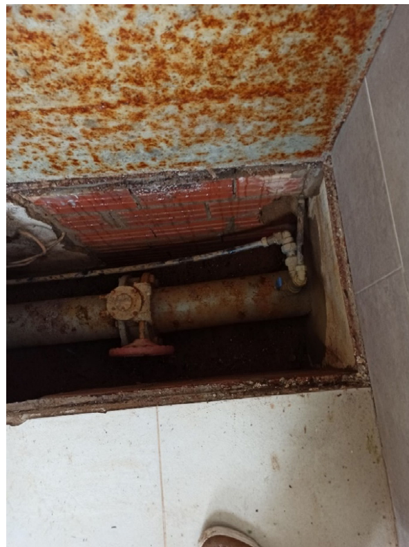
Figura 10. Canonada accés a vàlvula antiarriet
