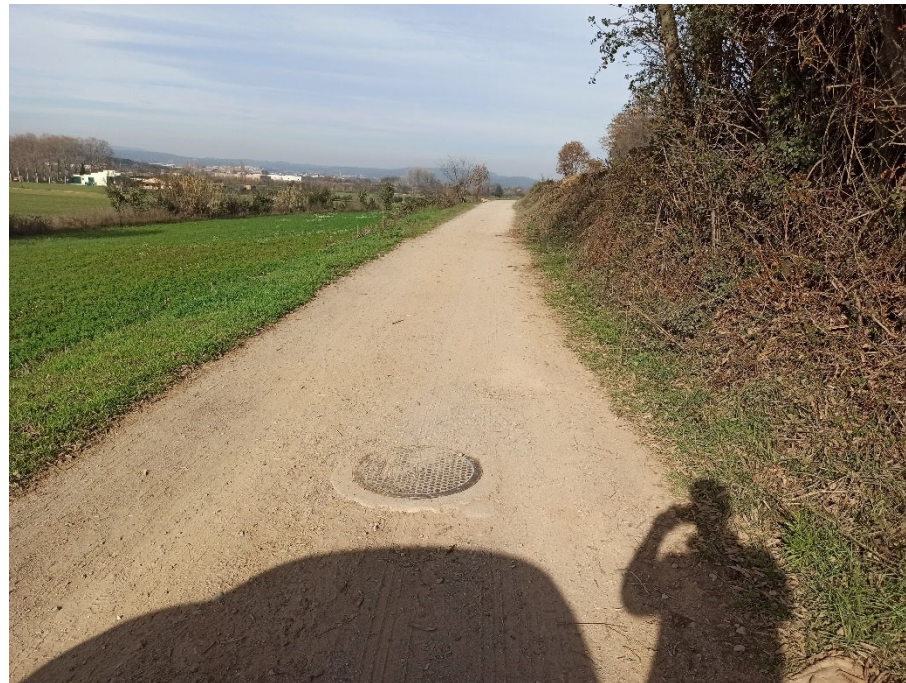
Figura 21. Traça de la canonada al PK 1+700 i arqueta ventosa. Vista en el sentit contrari de la traça
