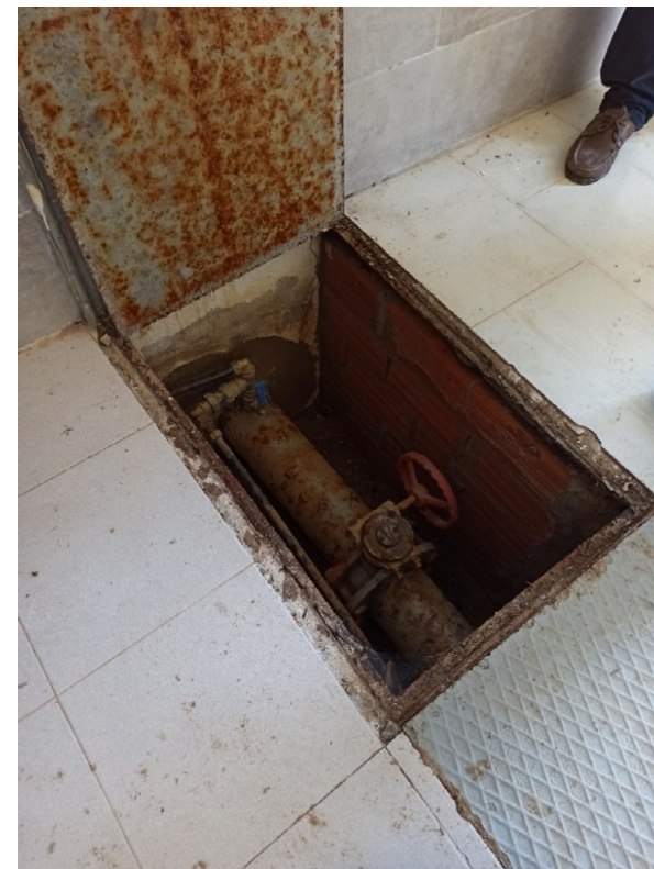
Figura 10. Canonada accés a vàlvula antiarriet
